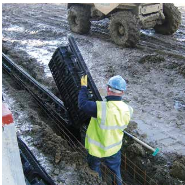
Elementos ligeros, instalados por un solo trabajador.
