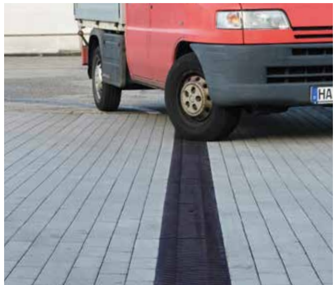
Instalación en superficies de pavimentación
